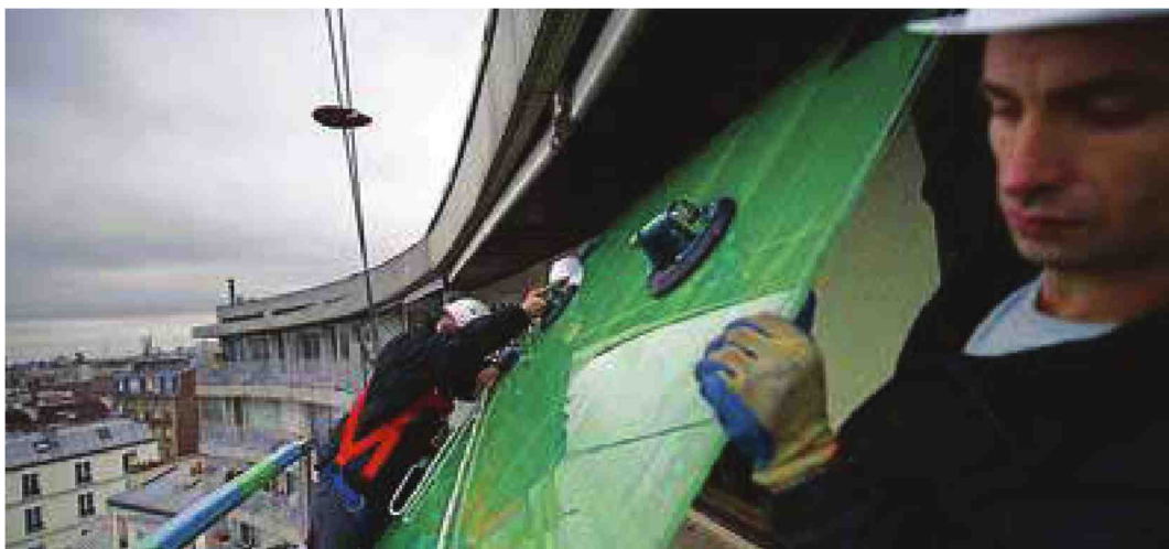
L'installation de double vitrage ne sera plus éligible au crédit d'impôt pour la transition énergétique. Photo Xavier Popy/RÉA
