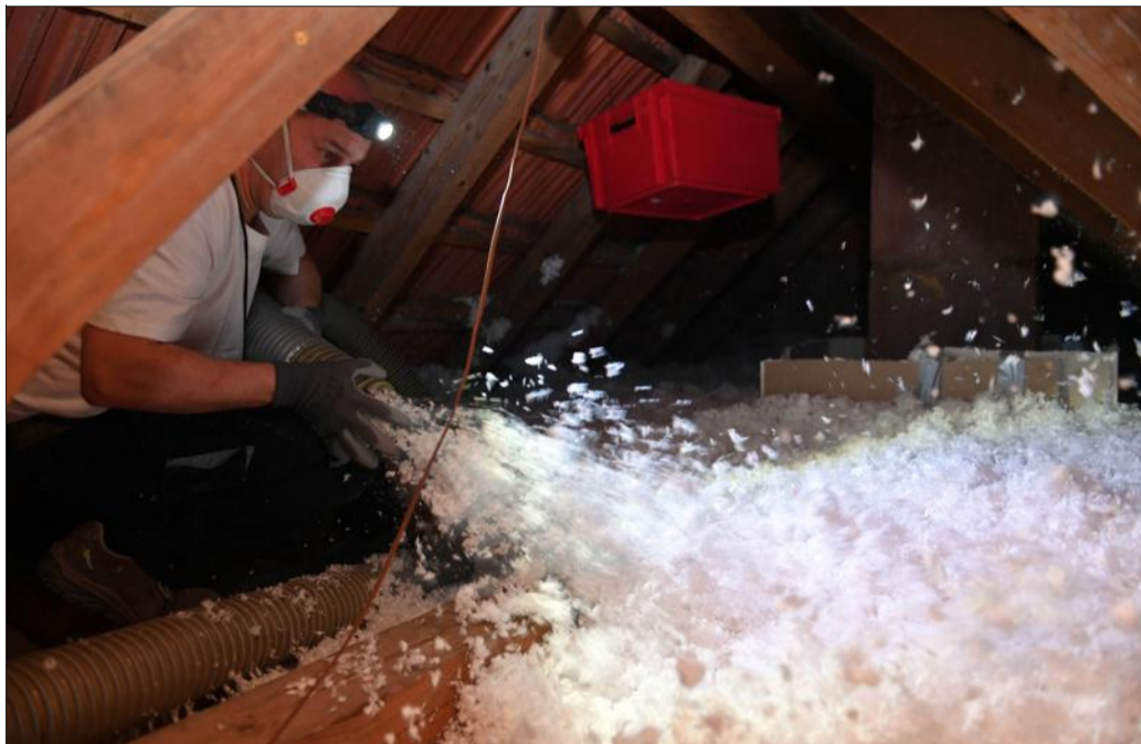
À Grendelbruch, ces combles ont été isolés dans les règles de l'art, pour un euro, avec 32 centimètres de laine de verre soufflée.
